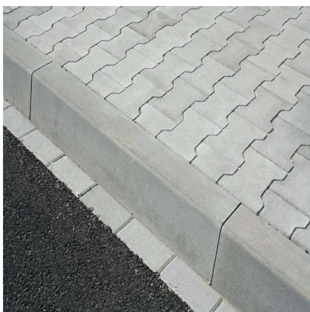
Betonový obrubník mezi vozovkou a chodníkem ze zámkové dlažby
